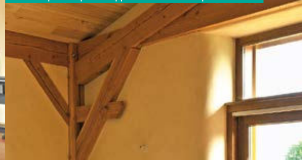
Structure poteau-poutre apparente et murs en paille arrondis
