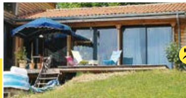
Vitrages à l'Ouest sans protection efficace
